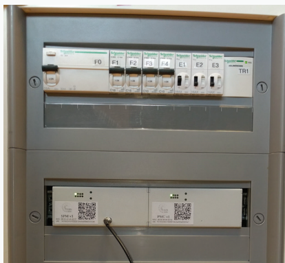
Merilni napravi SPM in PMC za podporo delovanju pametnih energetskih omrežij.
