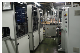
Sistem za avtomatsko končno kontrolo kvalitete izdelkov v tovarni elektromotorjev.
